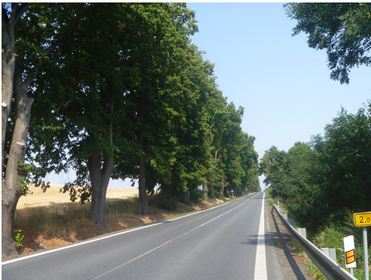
Obrázek 33: Místo se svodidlem [autor]
