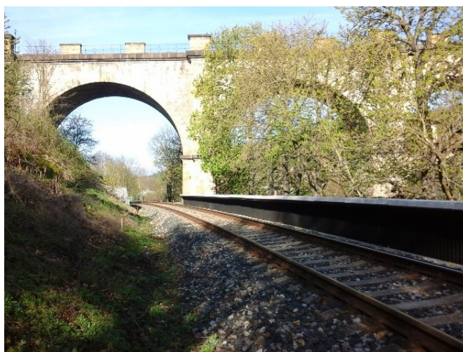
Obr. 5.3: Nízká protihluková stěna pod viaduktem BEB v Hlubočepích dne 11. 4. 2014 43
