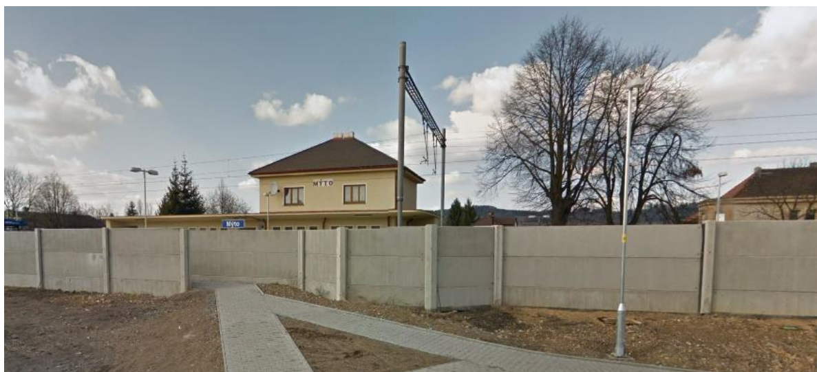
Obr. 11 Protihlukové stěny u výpravní budovy Mýto [14]
