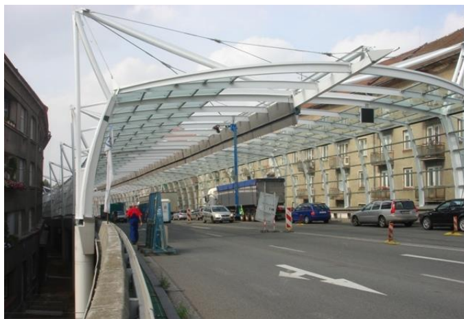
Obr. 4-4 Protihlukový tunel v Hradci Králové [11]
