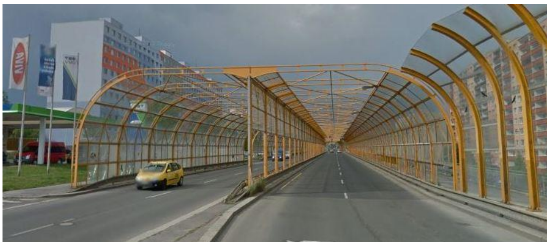
Obr. 4-1 Pohled na vjezd do protihlukového tunelu [maps.google.com]
