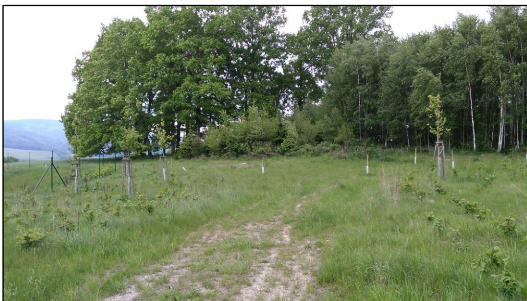
FOTO č. 4 Fotodokumentace, ekodukt Bílý Kostel nad Nisou [autor]
