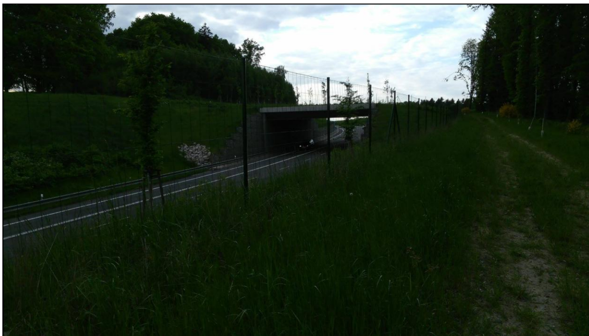
FOTO č. 1 Fotodokumentace, ekodukt Bílý Kostel nad Nisou [autor]
