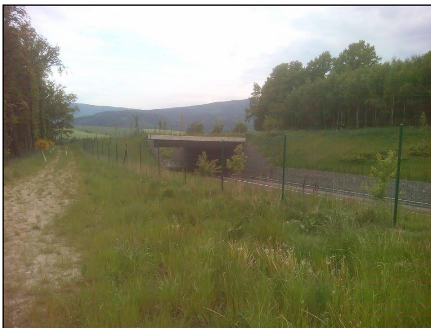
FOTO č. 5 Fotodokumentace, ekodukt Bílý Kostel nad Nisou [autor]
