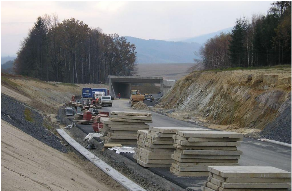
FOTO č. 6 Ekodukt u Bílého Kostela ve výstavbě [21]
