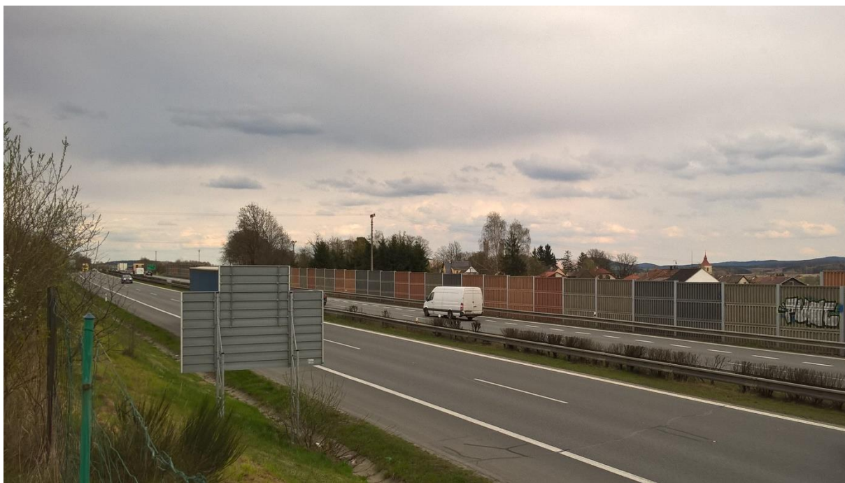
Obr. 16: Protihluková stěna podél dálnice D5 [3]
