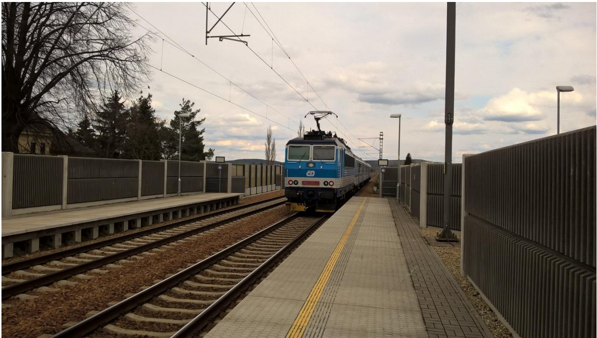
Obr. 17: Protihlukové stěny podél modernizované železniční trati [3]
