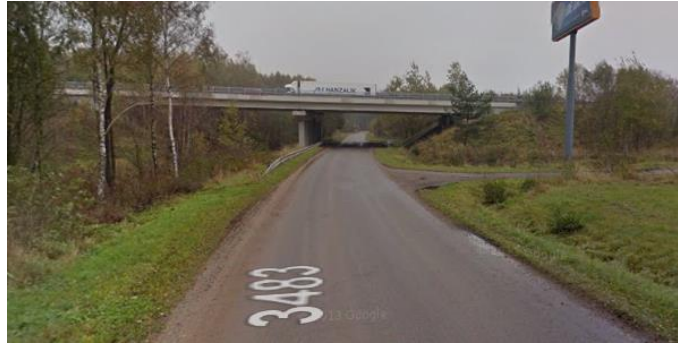
Obrázek 21: Dálnice D1 vedoucí po mostu [15]
