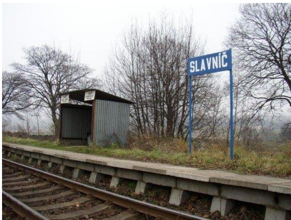
Obrázek 7: Železniční zastávka Slavníč [10]
